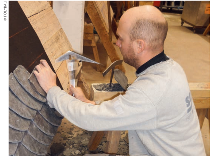
Christoph Zundel bei der Schieferdeckung.
