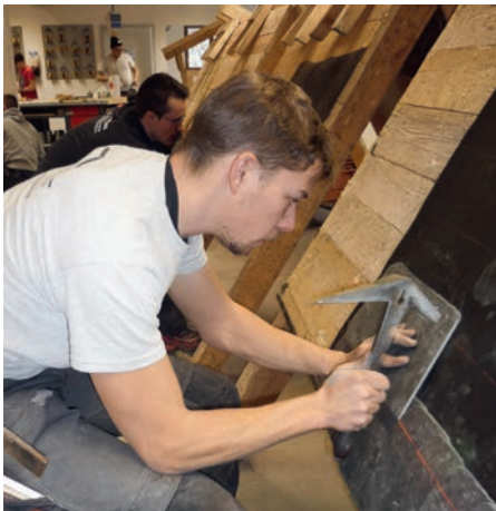
Daniel Wälti bei der Schieferdeckung.
