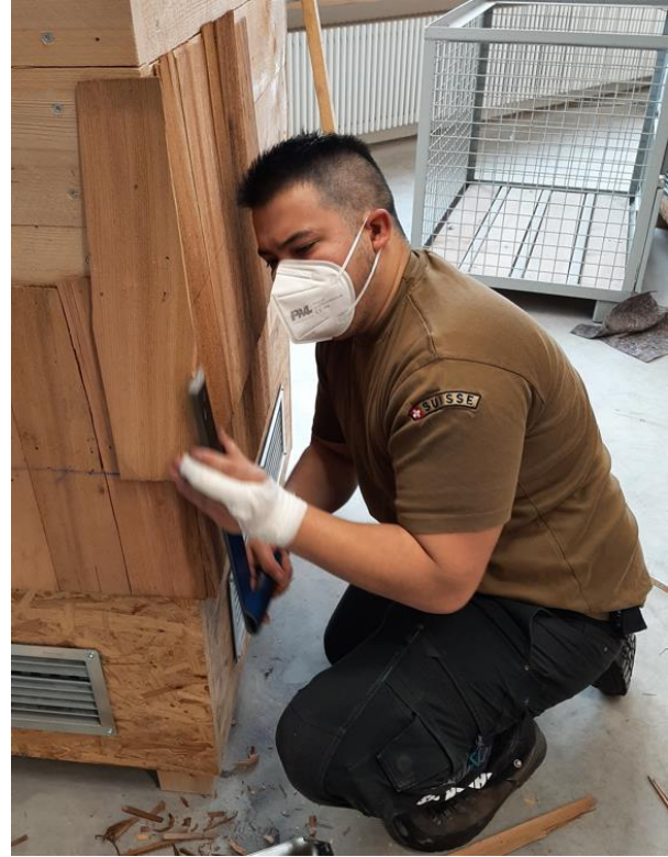
Abbildung 11: Daniel und Chris bei der Erstellung einer Holzschindeldeckung
