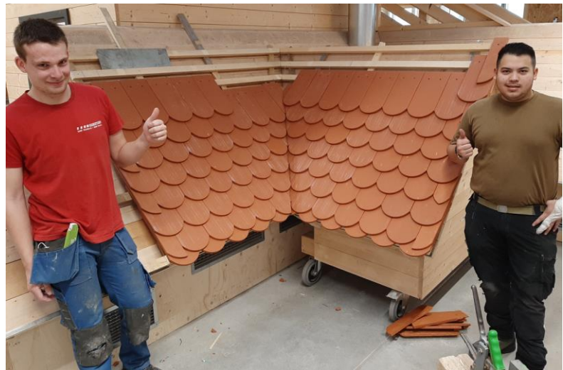
Abbildung 13: Erstellung einer Nockenkehle mit Biberschwanzziegeln
