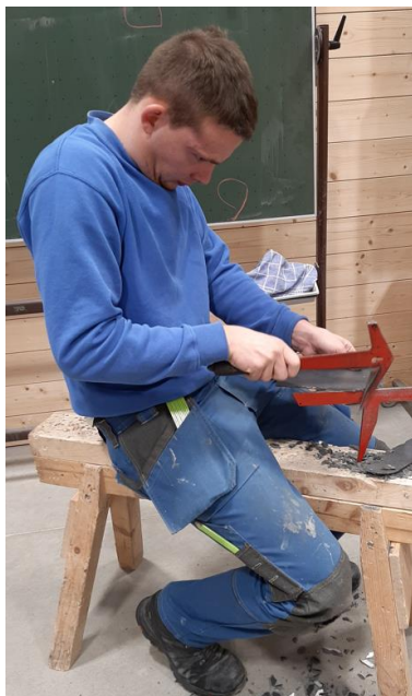
Abbildung 7: Daniel beim Erstellen einer Schieferdeckung
