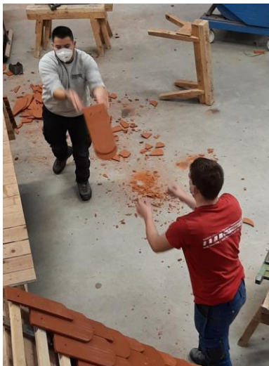
Abbildung 13: Erstellung einer Nockenkehle mit Biberschwanzziegeln
