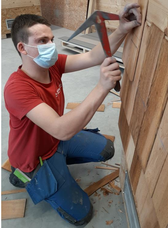
Abbildung 11: Daniel und Chris bei der Erstellung einer Holzschindeldeckung
